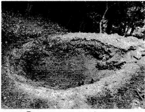
①土を取り出し
