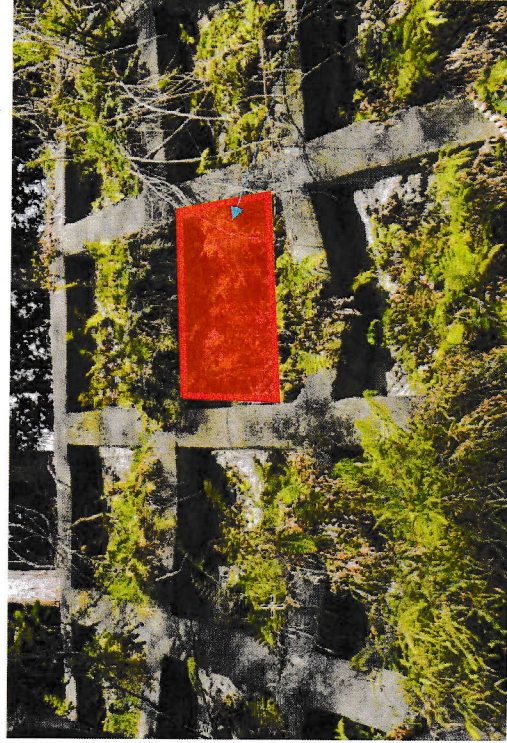
施工範囲 (既設法枠内補修)
